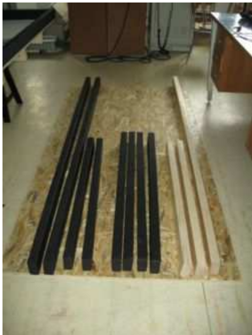
Materiál pripravený na montáž.
